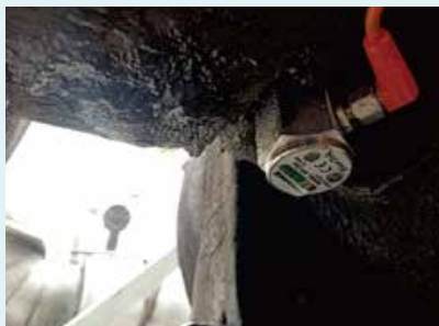
管路偵測流動情形
